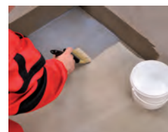
Penetrovat podklad - sjednotit savost.
