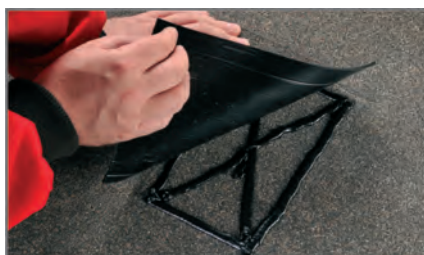
Po obvodu vytvořte rámeček. Záplata by měla být větší min. 10 cm na každou stranu od místa perforace.
