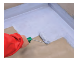
Provést celoplošnou aplikaci první vrstvy.
