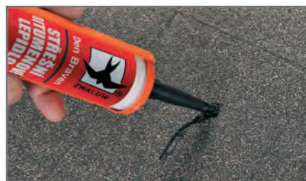
Okolí porušené izolace omyjte od zbytků listí popř. zbytků omítek a malt. Naneste Střešní bitumenové lepidlo do míst porušené hydroizolace.
