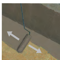
11 - Celoplošná aplikace první vrstvy.
