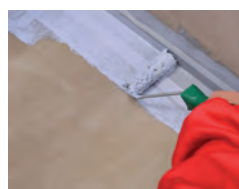
Vtláčit válečkem Těsnící pásy do svislých a vodorovných koutů.
