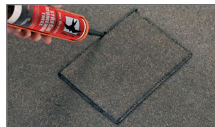
Pomocí Střešního bitumenového tmelu proveďte dotěsnění záplaty.
