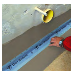
10 - Do prvního nátěru vtláčit Těsnicí pásy a rohy.
