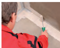
Nanést hydroizolaci na zbylá exponovaná místa.
