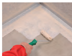
Provést celoplošnou aplikaci první vrstvy.
