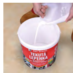
04 - Připravit si požadované množství od každé složky pro jednotlivé nátěry.
