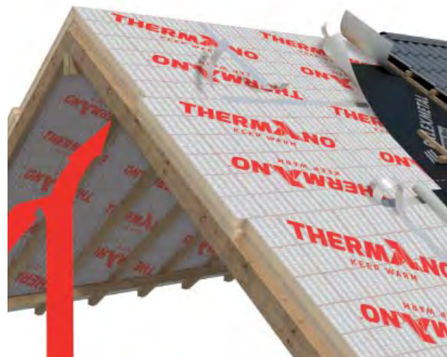
1. 5. | Nadkrokvovní izolace střechy deskami THERMANO , které brání unikání tepla.
