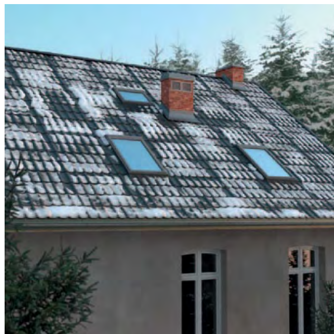
1. 3. | Příklad vzniku tepelných mostů – rozbředlý sníh je v místech pronikání tepla přes krokve na střeše.
