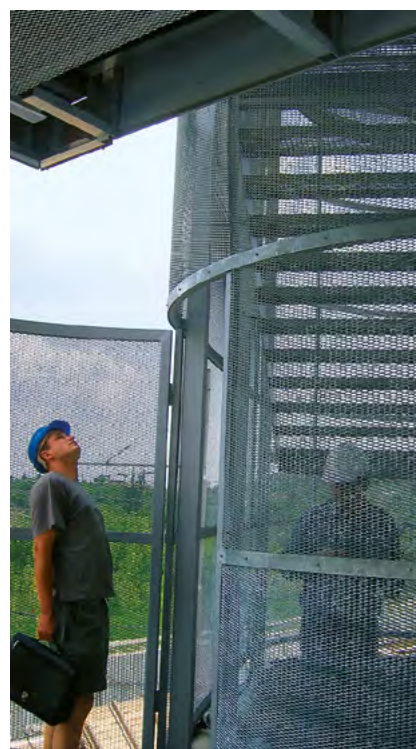
exteriérový zákryt schodiště
