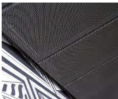
podhledové kazety Salmovský palác Praha
