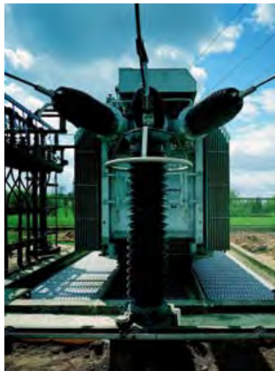
Systém zakrytí transformátorových jímek
