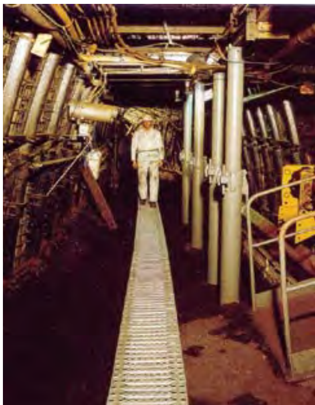
Pochůzná lávka v důlní chodbě
