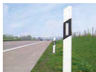
Silniční směrové sloupky
