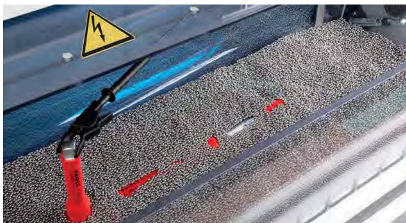
Zkouška vlastností elektrické izolace.
