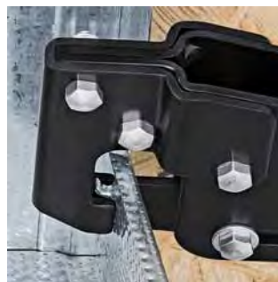
Nasazení kleští na dva spojované profilované plechy
