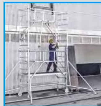
Nasazení zábradlí se vzpěrami...
