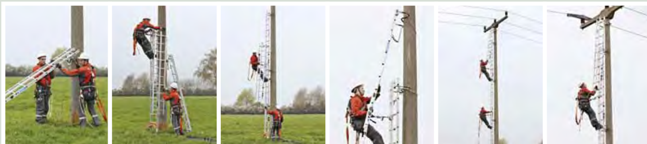
Montáž spodního žebříku
