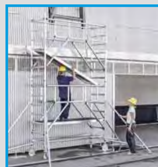
Nasazení plošiny z bezpečné pozice.
