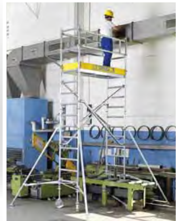
Lešení bez vzpěr ve dvou šířkách (0,75 a 1,35 m) a může být vysoké až 10,40 m. Prostor bez vzpěr až do 1,90 m.
